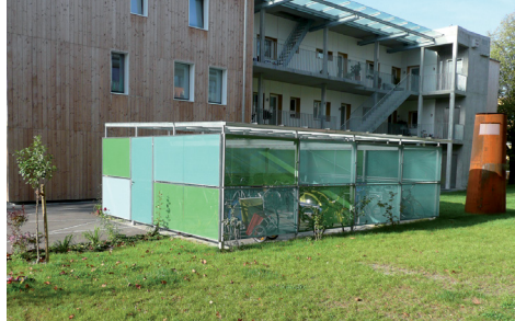
Veloparkierung in Nebengebäuden sind besser zu erreichen und günstiger zu erstellen als in Untergeschossen
