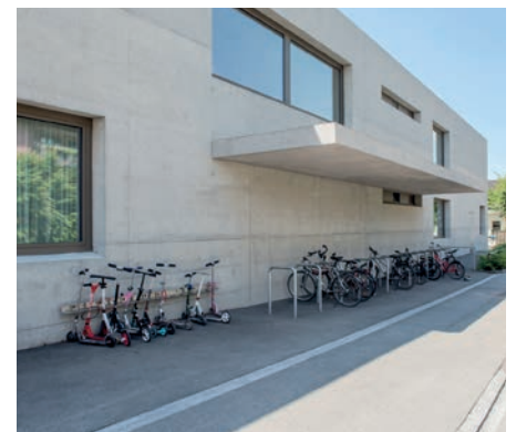
Anlehnbügel sind vandalensicher und einfach zu reinigen. Gute Lösung auch für Kickboards.
