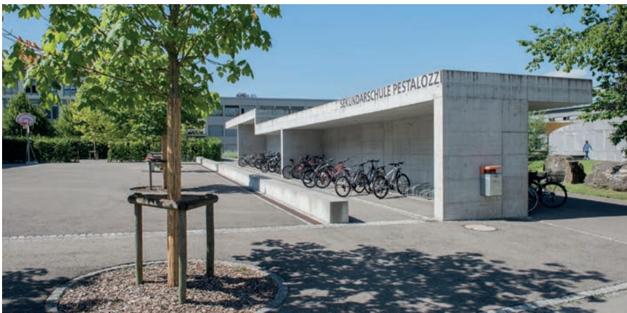
Aus den Klassenzimmern einsehbare Veloparkplätze beugen Vandalismus und Diebstahl vor.
